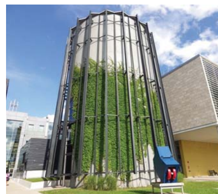
Le Colosse, un superordinateur installé dans l'ancienne structure en silo de l'accélérateur de particules remporte de nombreux prix d'efficacité énergétique.
