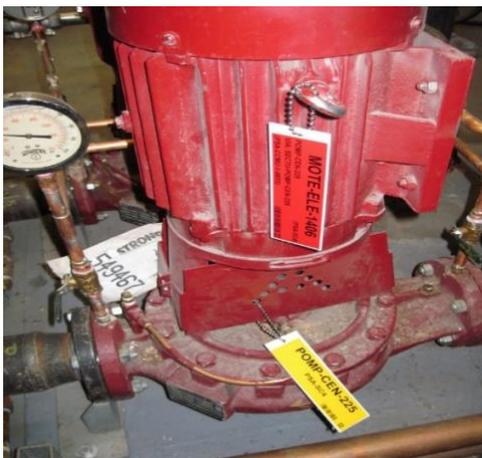
Photo 7. Pompe centrifuge et moteur électrique
