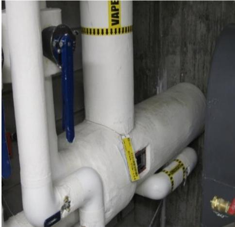
Photo 14. Échangeur à tubes
