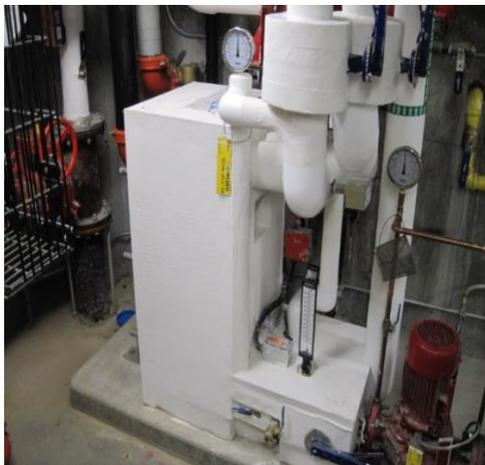
*Photo 13. Échangeur à plaques*
