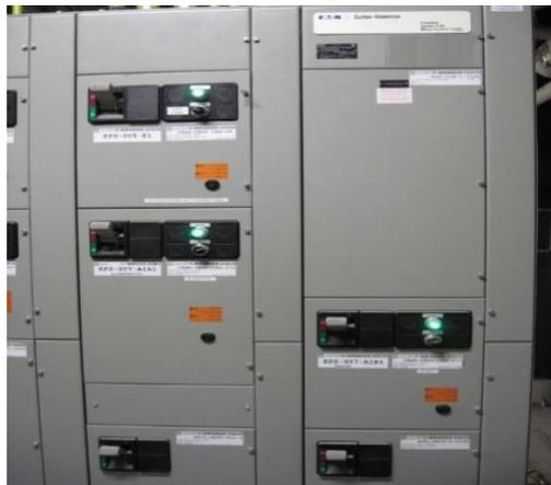
Photo 17. Centre de contrôle moteur (CCM) et démarreurs
