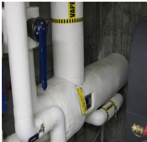
*Photo 18. Échangeur à tubes*
