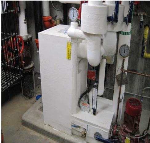
*Photo 17. Échangeur à plaques*
