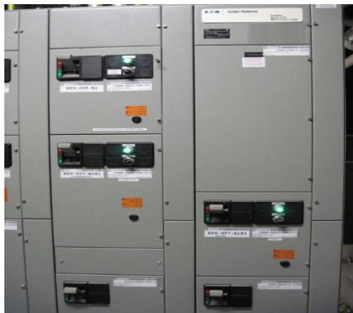
Photo 21. Centre de contrôle moteur (CCM) et démarreurs
